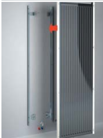
3 Montage van het verwarmingselement. Aansluiting toe- en afvoerleidingen van de thermostaat.
