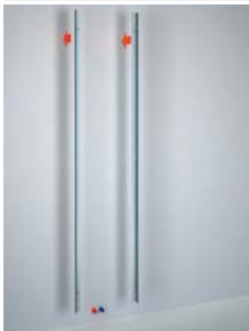
1 De wandbevestiging aanbrengen en vastschroeven.
